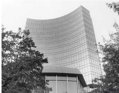
Bâtiment de l'OMPI à Genève
